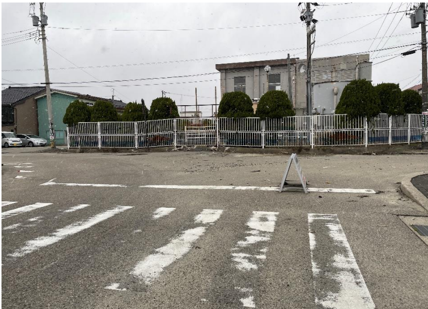
七尾市内 被害状況
