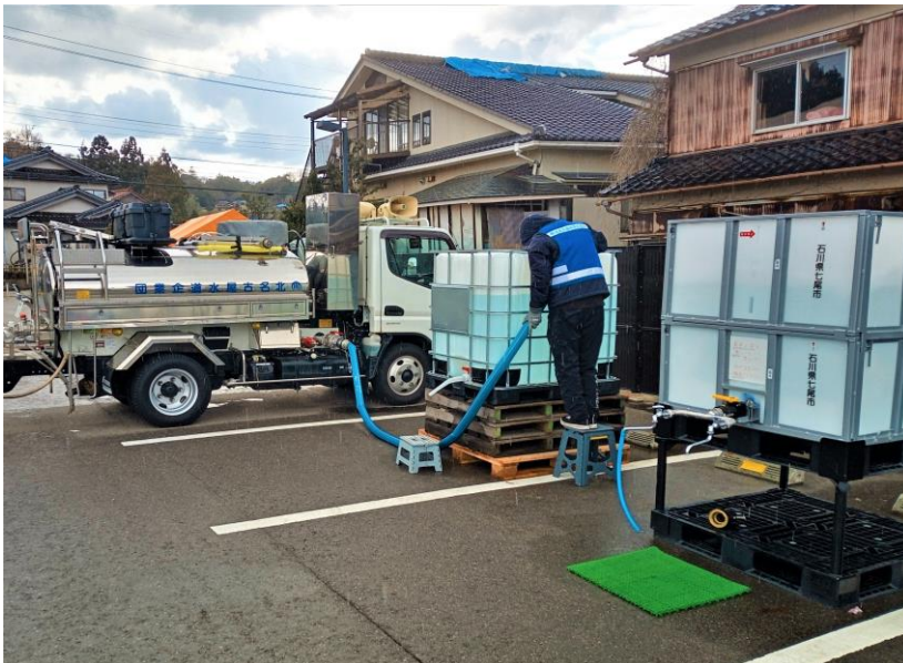
仮設水槽への給水 (七尾市内 給水支援所)
