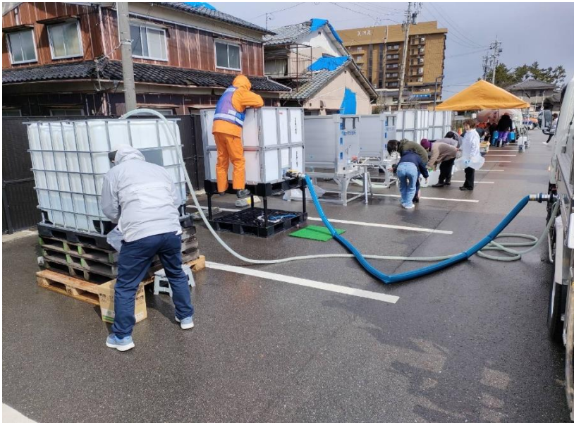
組立式仮設給水槽への給水 (七尾市内 給水支援所)
