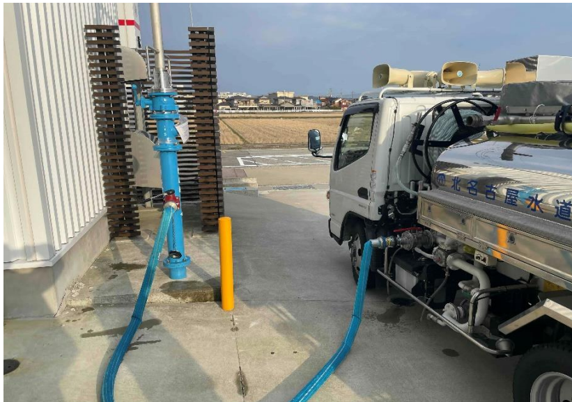
氷見消防署柳田出張所にて 給水車への補水 (氷見市内)
