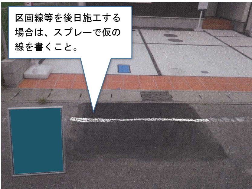
舗装本復旧の状況 (再生密粒度アスコン)
