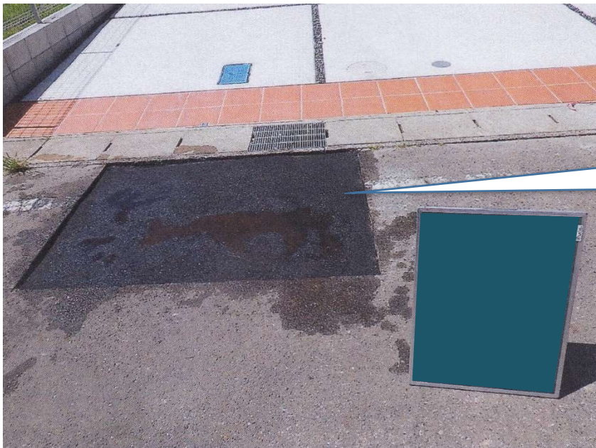
舗装本復旧の状況 (タックコート)
