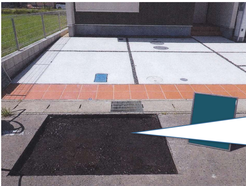
舗装本復旧の状況 (プライムコート)
