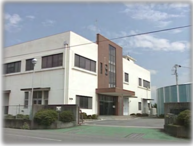
師勝配水場管理棟
