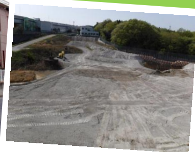
藤岡最終処分場
